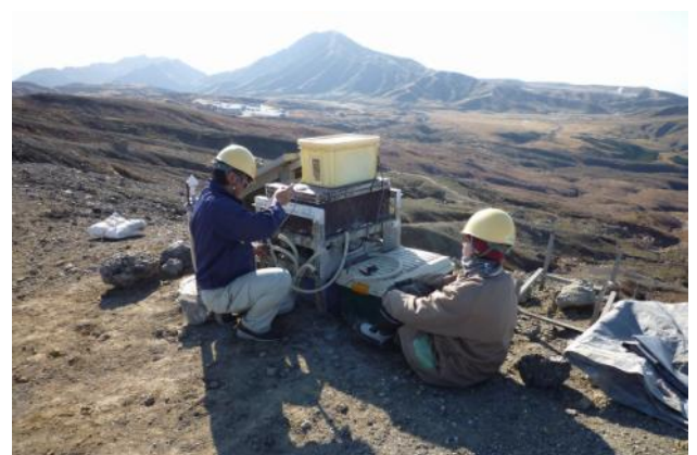
写真2 伝送装置の交換作業の様子
