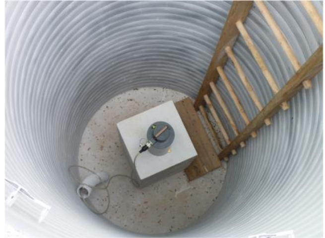
写真2 新たに設置された磁力計 3mの深さの竖穴の中に設置された
