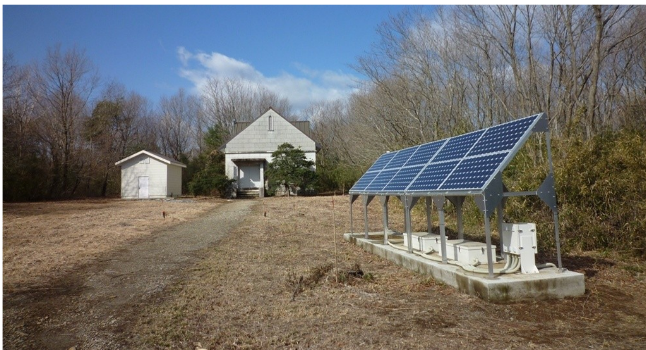
写真3 地下変化計室上屋（奥左）、機器を収納した第一絶対観測室（奥中央）と、電源装置（手前右）
