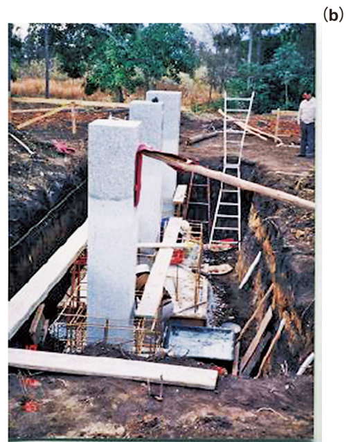
図6 (a) 絶対観測室の器械台の設置のため掘削した地面の範囲 (ハッチングで囲った部分) 掘削した深さは 2.0 m。 (b) 器械台設置工事の写真。東側から西向きに撮影。
