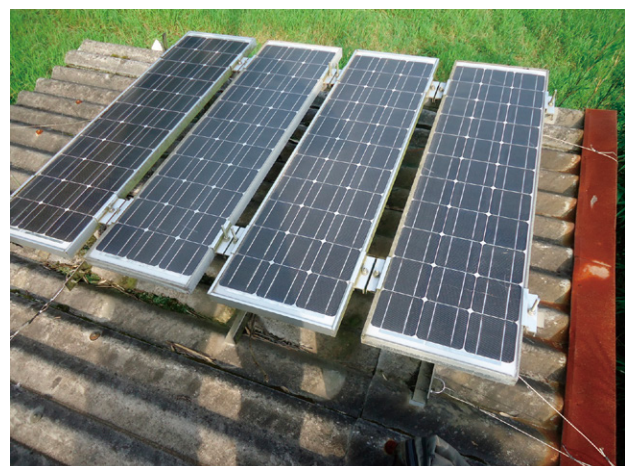
写真6 AHK 電源装置改修後
